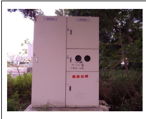
圖 4-3-1：臺電低壓供電
