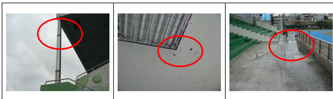
圖 4-2-7：鋼柱生鏽
