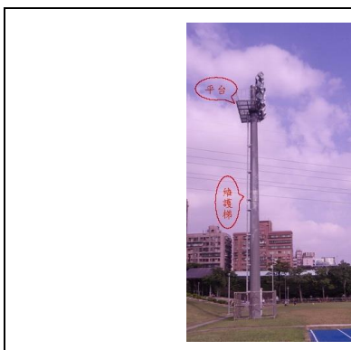
圖 4-3-3：新柱維護梯及維修平臺
