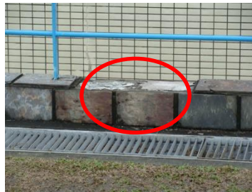
圖 4-2-17：面磚損壞
