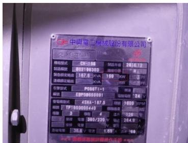
圖 4-3-4：發電機 150KW
