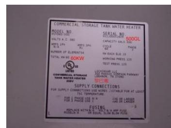
圖 4-3-9：儲水式電熱器 (黎巴嫩製)
