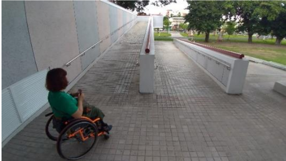
體育館斜坡（過長不適合輪椅使用者使用）
