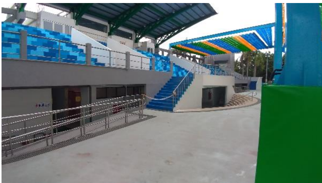
坡道、樓梯全景
