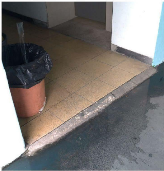
該廁所外走廊與北門斜坡高低差斜角處理
