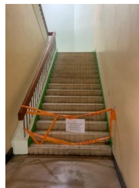
館內設置之樓梯
