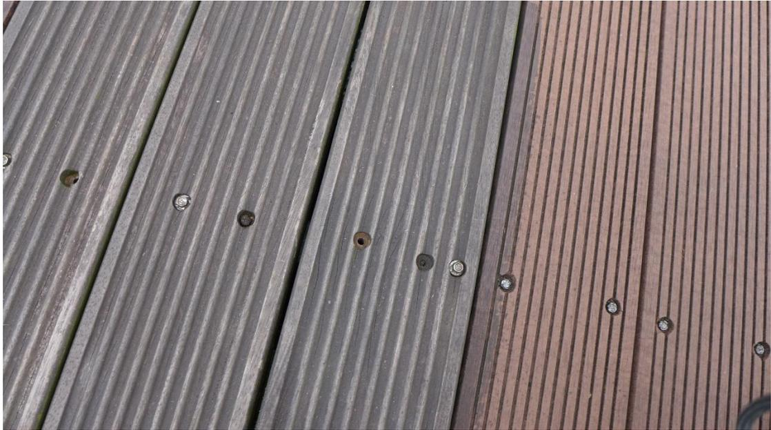
圖：自行車橋面螺絲脫落，車輪壓過鋪板會彈跳。
