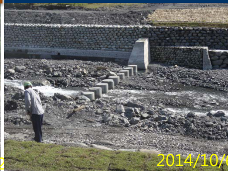
低落差固床工與砌石護岸
