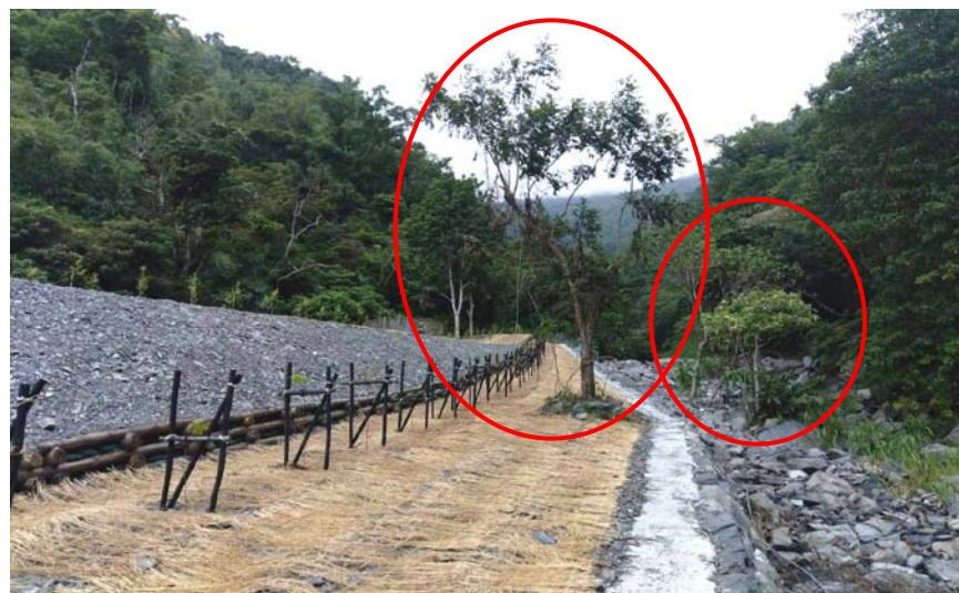
護岸以多孔隙高透水設計，採現地石材、木格框擋土牆、保留現地樹種、並配合植栽復育
