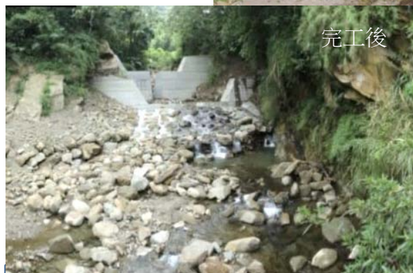
大埔區第53林班野溪治理工程
