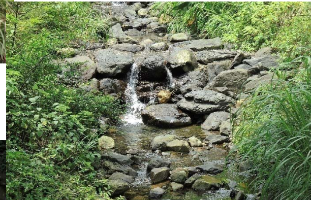
梗枋南溪上游及支流整治二期工程
