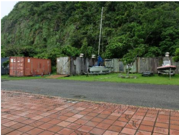
豆腐岬基礎設施-活動式艇庫
