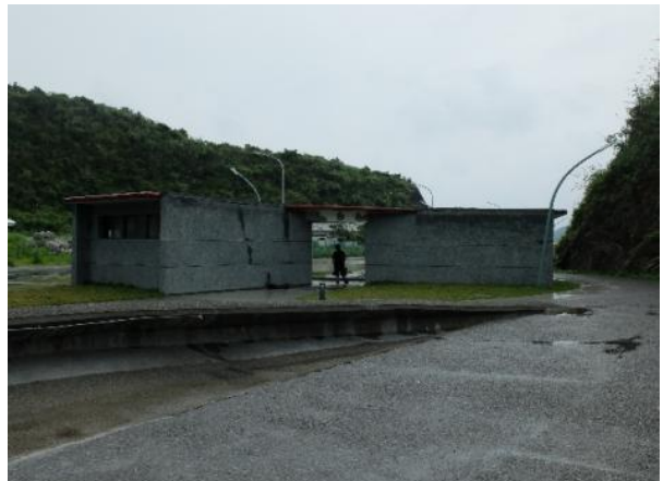
豆腐岬廁所(含淋浴設備)
