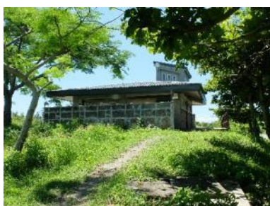
的固定式廁所(含淋浴設備)
