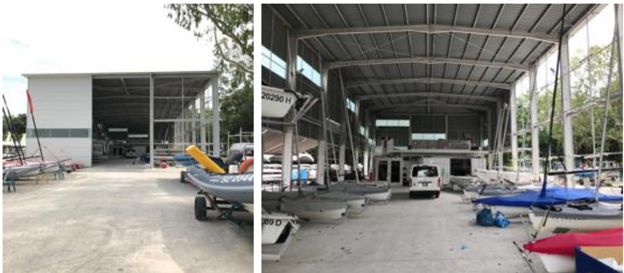
室內複合式艇庫（新加坡國家帆船中心）
