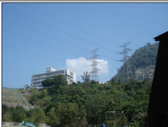
水里溪上游處的臺電明潭電廠
