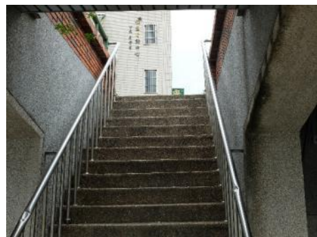
水里溪供搬運船艇之樓梯
