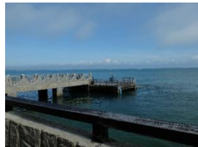
觀音亭水岸設施-浮動平臺與聯絡棧橋
