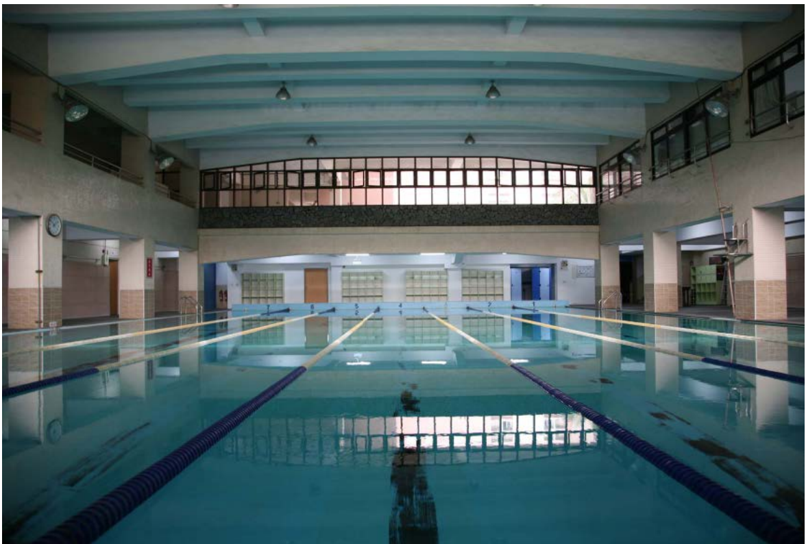
學校游泳池二樓內側為採光及通風窗之設計，兩側可形成自然對流通風。
