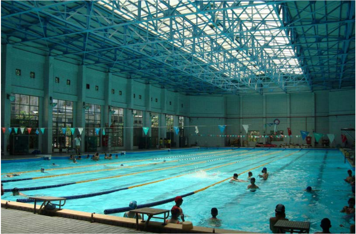
室內溫水游泳池可於屋頂設計採光面材，以增加白天之自然採光，節省電費支出。
