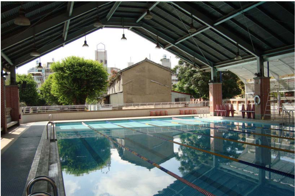
游泳池鋼構遮陽頂棚，類似風雨操場之建築構造模式。
