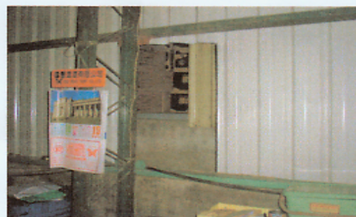
被挖開之洞口
