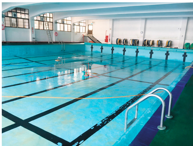
泳池竣工多年，皆需進行小規模的整修。（圖片提供／莊淑婷）
