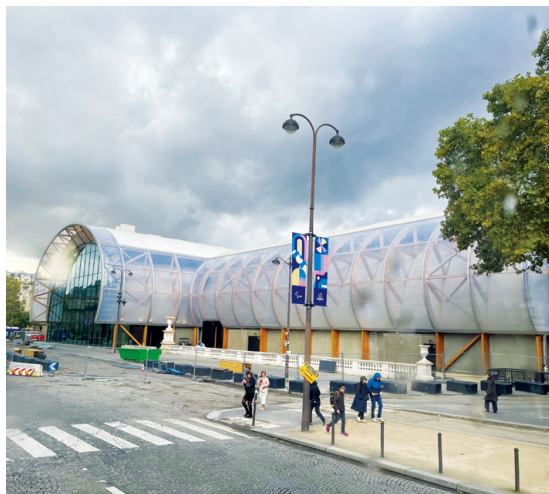
▲ 圖2／戰神競技館（Champ de Mars Arena）所搭建的結構與木材皆使用永續建材，外層以透明防水布覆蓋，兼具隔音、隔熱與可回收利用特性，奧運會舉辦後即可拆除（圖片提供：作者）
